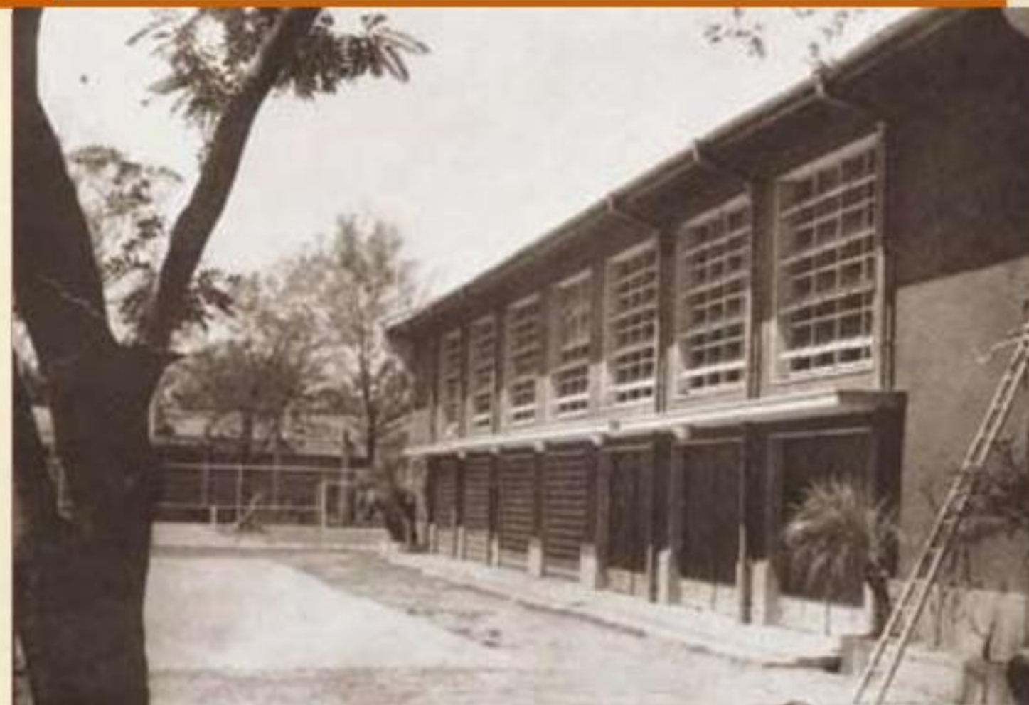
圖14：成功堂改建時臨球場之7座大門中的4座封以空心水泥牆，僅留3座，但於另一側對稱面，則同時開門3座，本圖採自民國56年畢業紀念冊。
