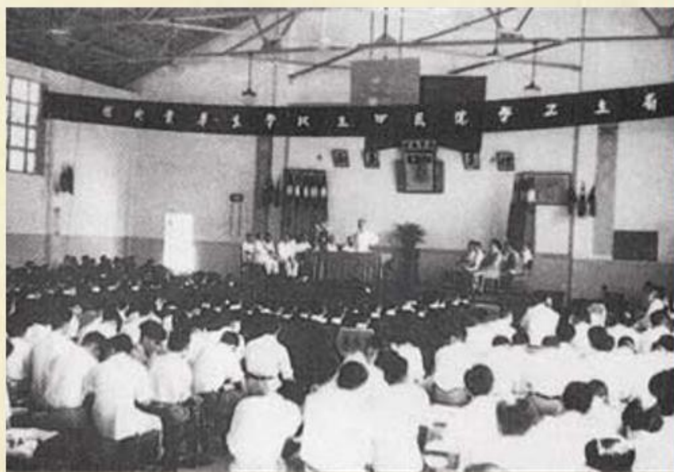
圖7：43級畢業典禮時於成功堂舉行，當時成功堂尚未增設天花，可以清楚的看到屋架形式是鐵製的桁架結構。
